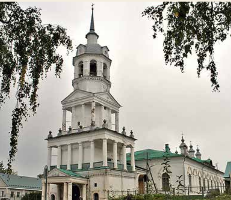
Арх нгельск я церковь в селе Кстинино, прихож нином которой был Юрий Чирков
