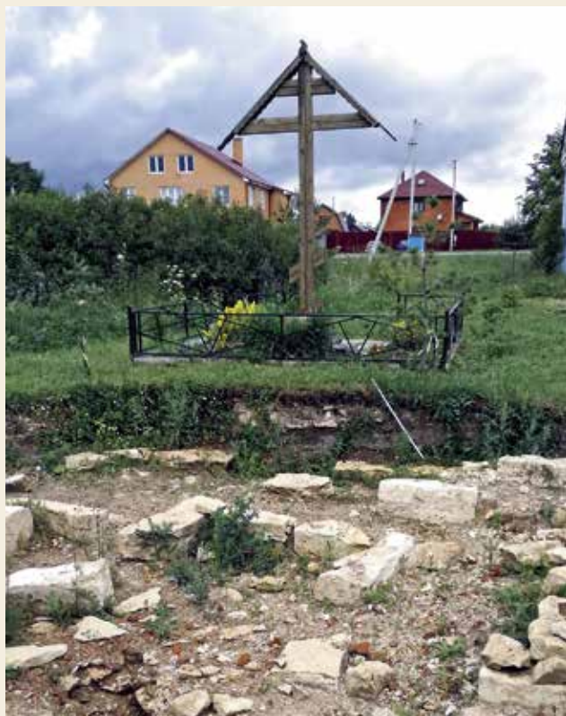
Фундамент разрушенного храма
